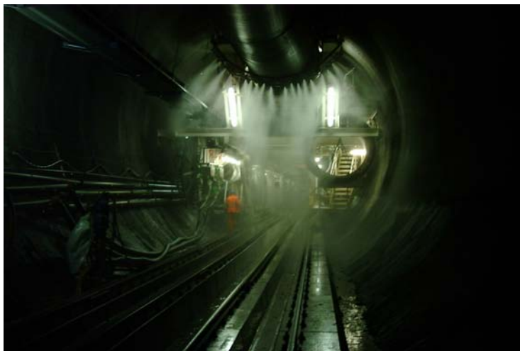
BILD 5: Wassernebelvorhang beim TBM-Vortrieb
