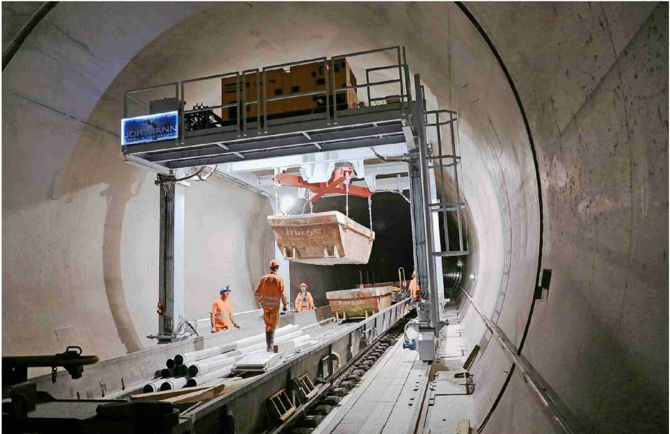
Sämtliches Material wurde per Eisenbahn durch den Basistunnel an- und abtransportiert. Foto: PD
