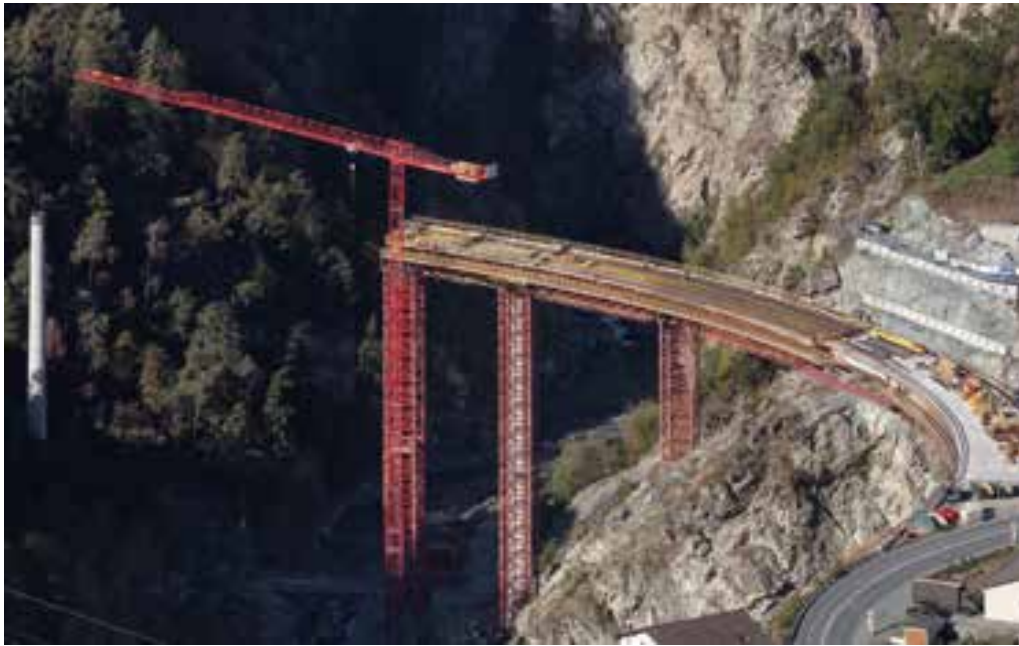
23 Lehrgerüst in Bauphase 2 © Thomas Andenmatten
