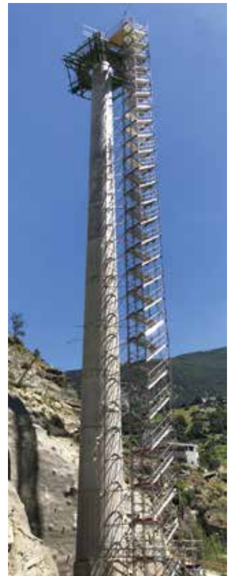
12 Pfeiler 1 mit Kletterschalung und Treppenturm © Wolfgang Linder
