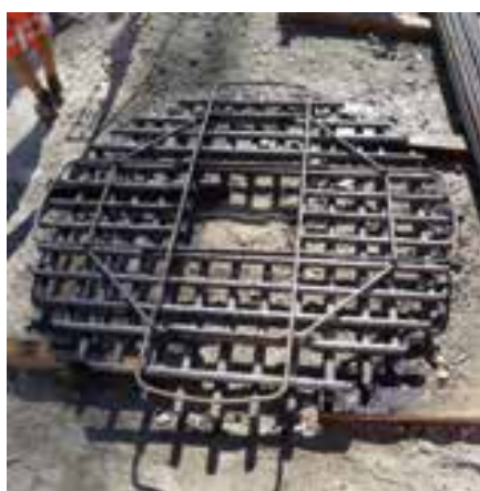
22 Bewehrungsrost am Pfeilerkopf © Wolfgang Linder
