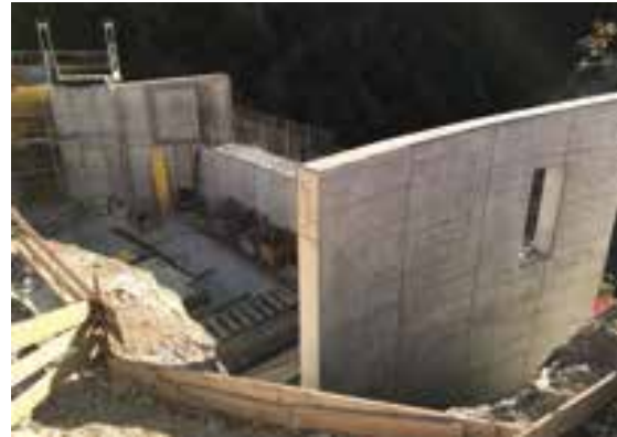
14 Widerlager Nord mit Querträger-Anschlussbewehrung © Wolfgang Linder
