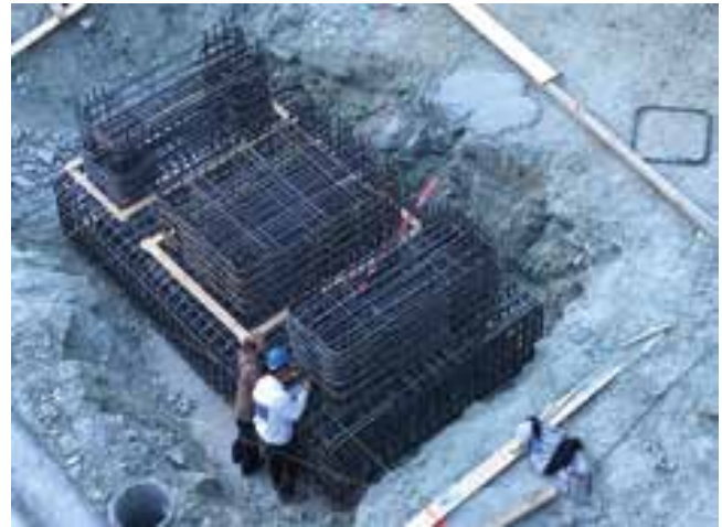
16 Bewehrung des Zwischenauflagers © Wolfgang Linder
