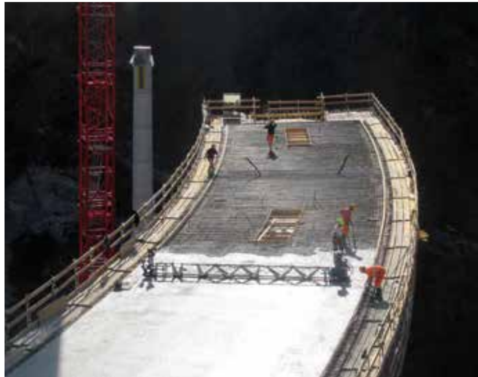
28 Betonieren der Fahrbahnplatte in Etappe 2 © Oriana Cordaro
