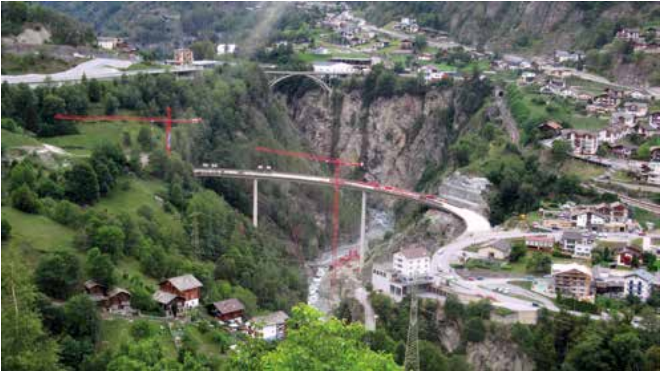
42 »Horizontale« Bogenbrücke im August 2019 © David Bumann
