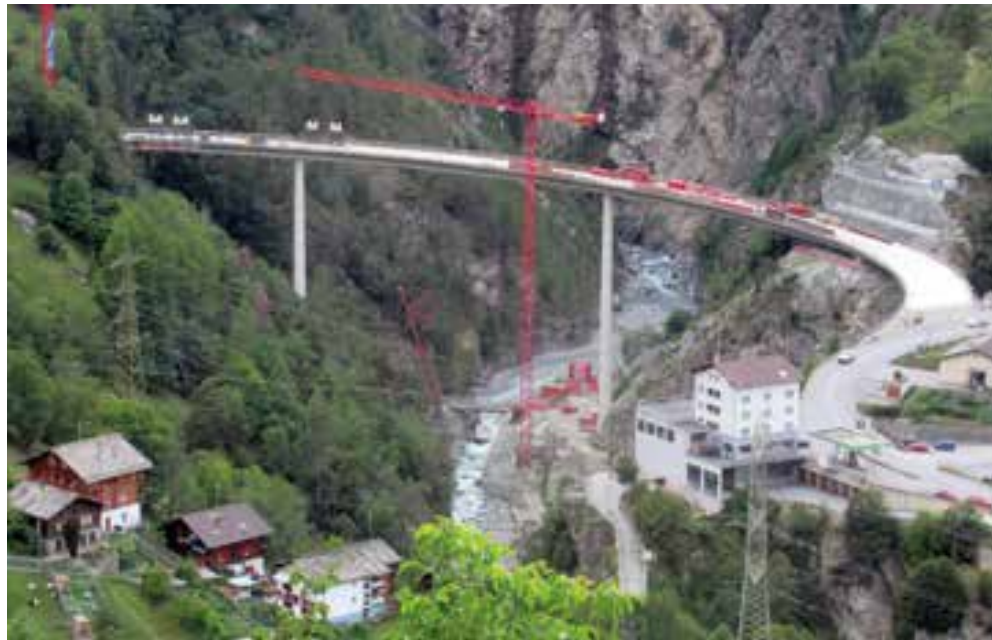
1 Chineggabrücke © SRP Ingenieur AG
