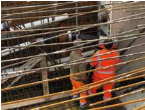
27 Montage der Spannliedkopplung in Feld 4 © Wolfgang Linder
