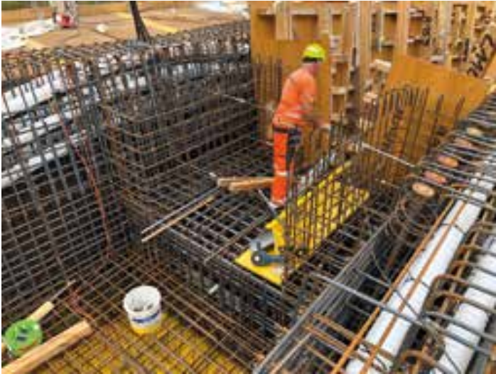
25 Querträgerbewehrung über Pfeiler 1 © Wolfgang Linder
