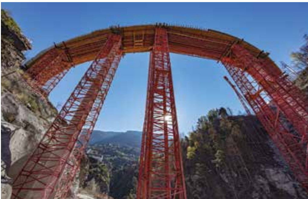
24 Lehrgerüst in Bauphase 3 © Thomas Andenmatten
