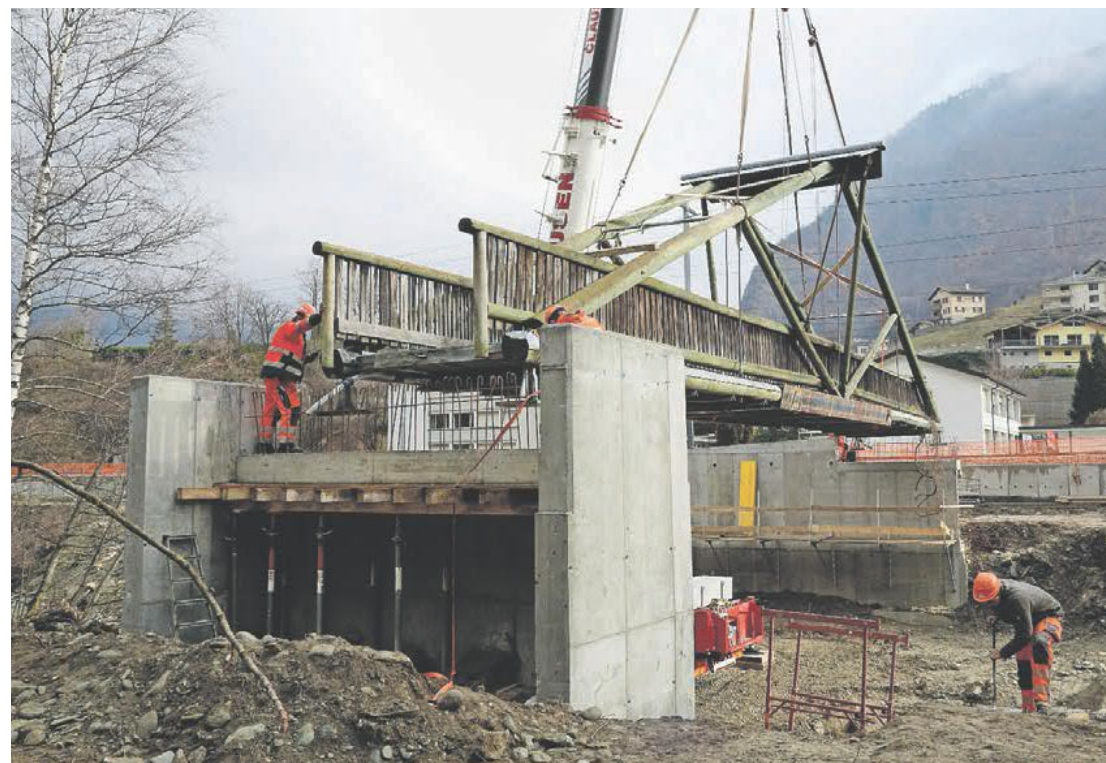
Die Brücke wurde am neuen Standort millimetergenau eingepasst.
